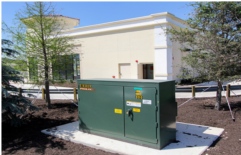
Transformadores tipo pedestal, para exteriores
